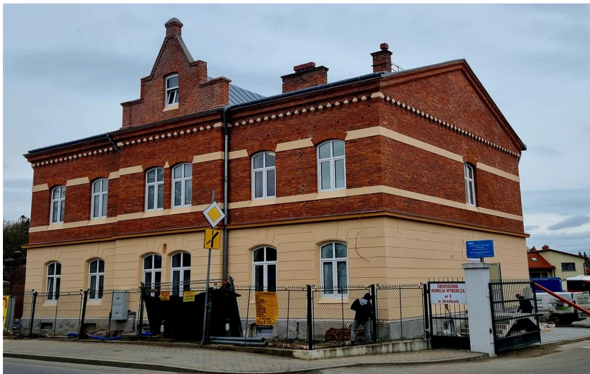
Rysunek 3 Budynek administracyjny MZK zaadaptowany na Informatyczne Centrum Zarządzania Miastem i Punkt Pozyskiwania i Obsługi Inwestora
